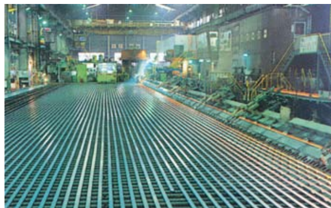
冷却床 Cooling bed
