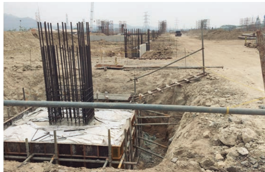
建設工事風景
